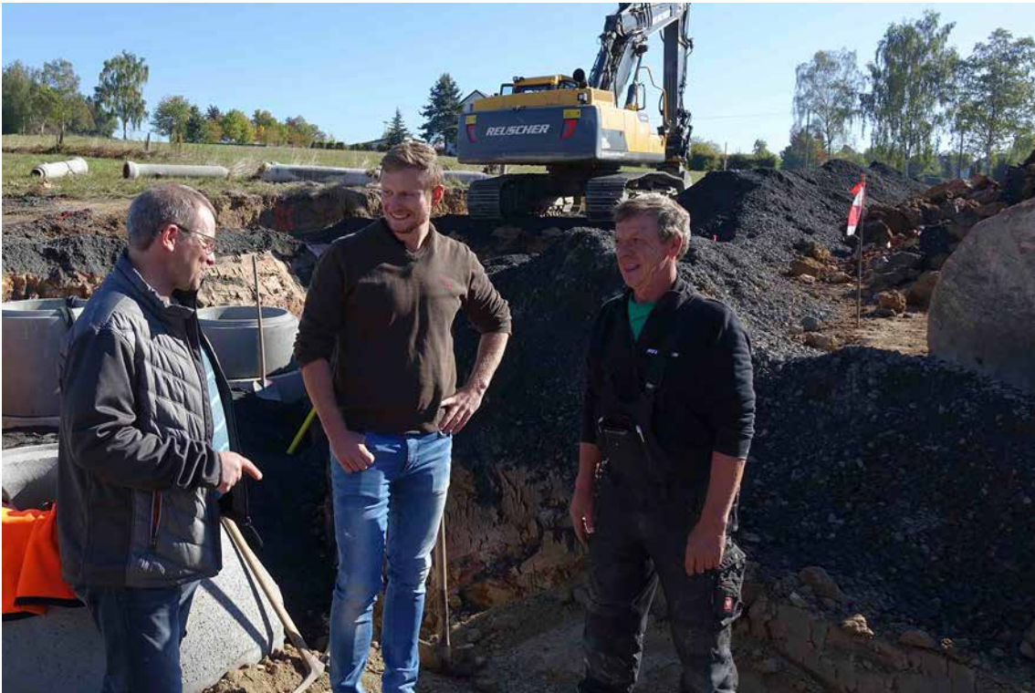
Mit dem Ablauf der Arbeiten zufrieden: Stephan Werlich vom Bauamt der Stadt Hadamar, Fachberater Christopher Wusch und Schachtmeister Karl-Heinz Schoch, v.l.n.r.
