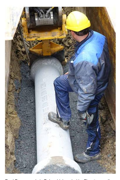
Zwei Bagger und ein Rohrschieber sind im Einsatz, um die FABEKUN®-Kanalrohre und -Schächte zu verlegen.
