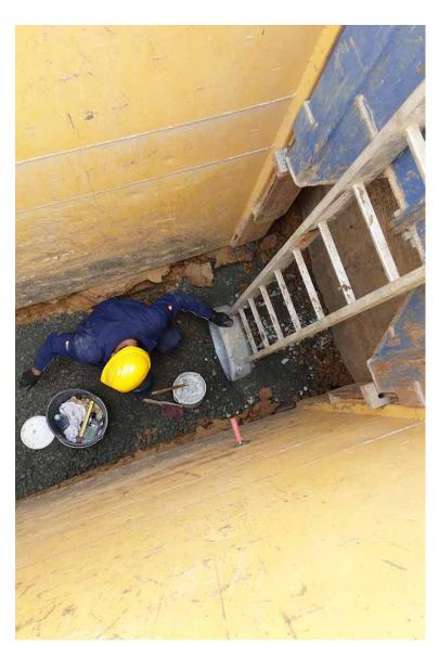
Ein Mitarbeiter der Walter Feickert GmbH schmiert mit dem Gleitmittel sowohl das PVC-Spitzende als auch die Dichtung auf dem Betonspitzende sowie die Muffen von Beton- und Kunststoffrohr ein.
