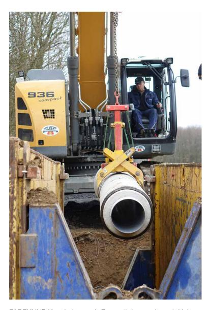
FABEKUN®-Kanalrohre und -Formstücke werden mit Hebezeugen, die ein gleichmäßiges Heben und Senken erlauben, in den Rohrgraben abgelassen.
