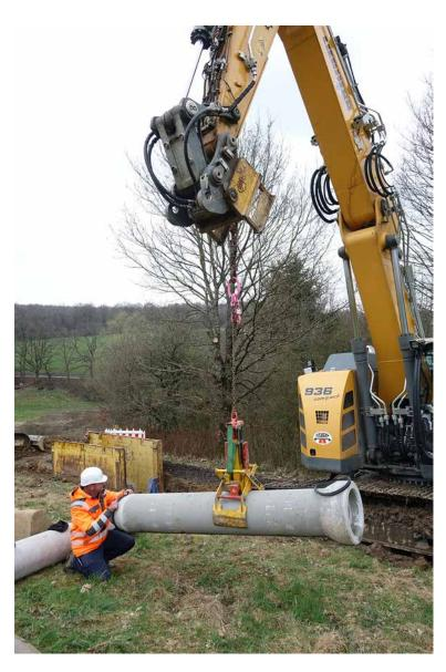
Die FABEKUN®-Kanalrohre werden mit dem Hebezeug mittig gegriffen – auf diese Weise kommt es nicht zu Beschädigungen an Muffe und Spitzende.
