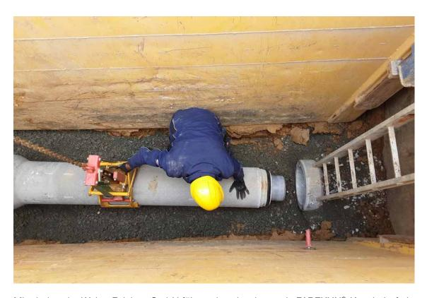
Mitarbeiter der Walter Feickert GmbH führen das einzubauende FABEKUN®-Kanalrohr frei hängend in die Muffe des bereits verlegten Kanalrohrs ein. Auf diese Weise lässt sich die Rohrverbindung zwängungsfrei herstellen.
