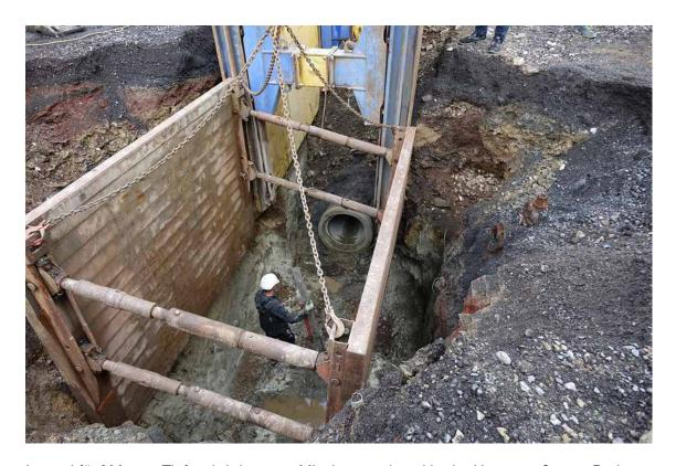
In rund fünf Metern Tiefe wird der neue Mischwasserkanal in der Hauptstraße von Puderbach verlegt.
