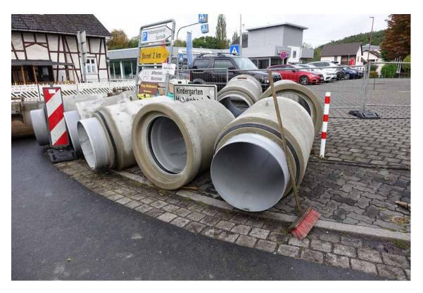
Bereit zum Einsatz: Aufgrund guter Erfahrungen bei einer Baumaßnahme im Trinkwasserschutzgebiet in Lautzert setzen die Verbandgemeindewerke Puderbach auch bei der Erneuerung des Mischwasserkanals im Ortskern Puderbach auf FABEKUN®-Rohre und -Schächte.
